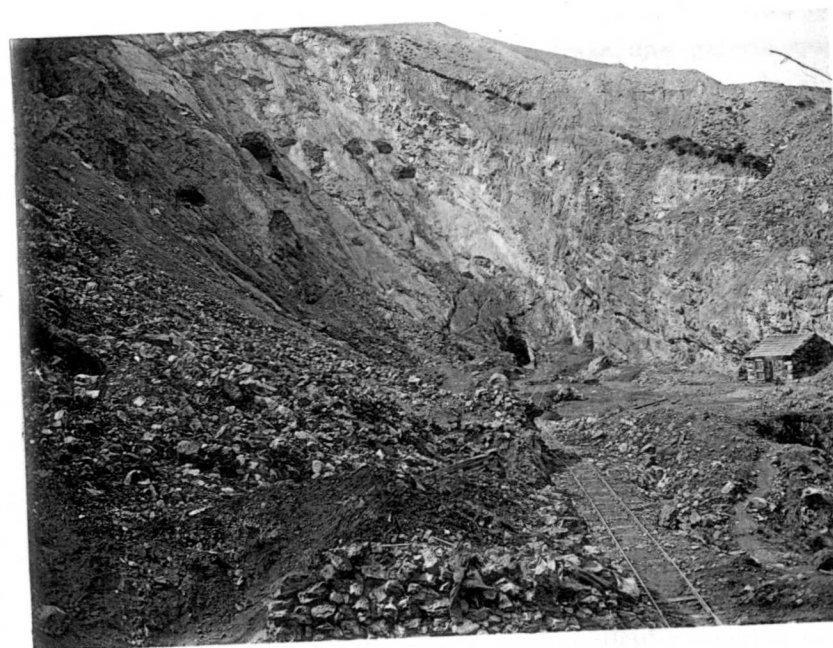
Cantera de escombros en la Grada Cuatro, para surtir de relleno a las galerías inferiores.
