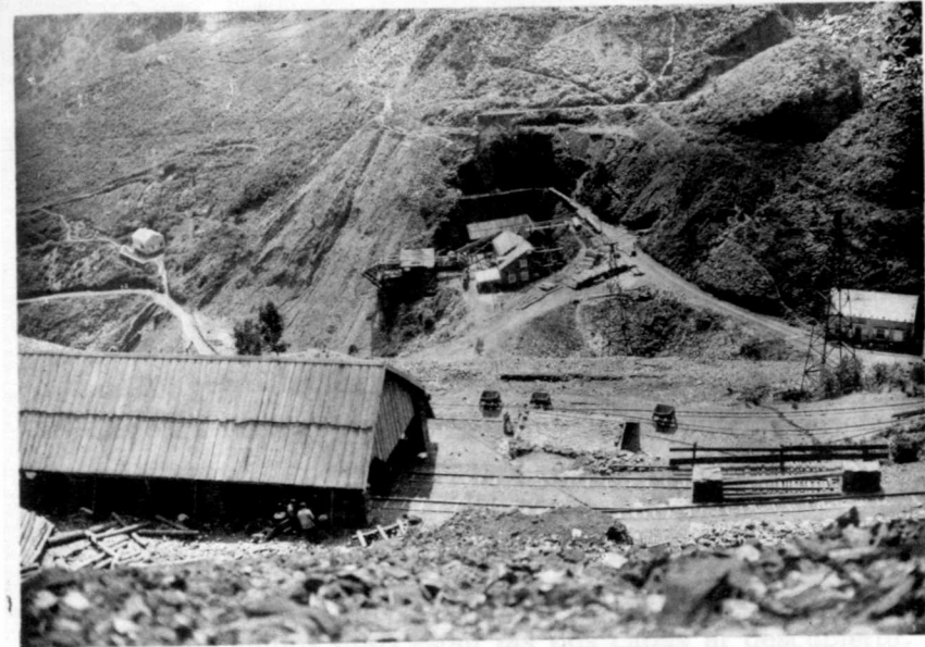
Estación de ángulo, cobertizo de clasificación y depósitos de la galería Ventilación.
