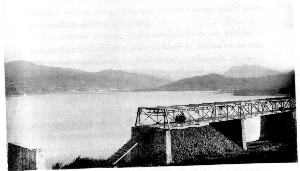
Cargadero de mineral. Depósitos inferiores.
